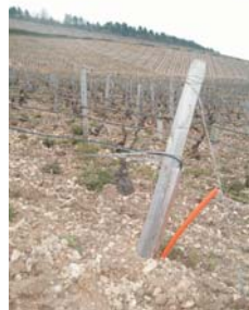
Câble chauffant disposé sur le fil porteur
